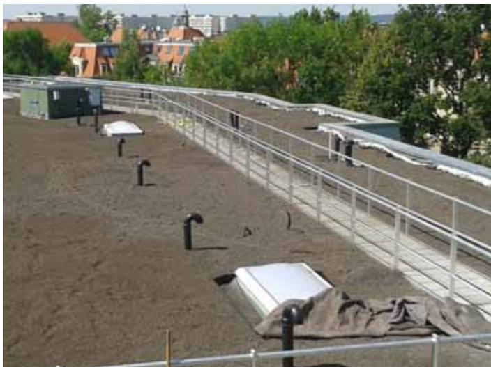
Zum Beispiel gehört das **SAUVGUARD II** zu der neuen Generation von Dachgeländern. Dieser Seitenschutz erlaubt einen erheblichen Produktivitätsgewinn bei der Montage. Die Auslegeschiene und der Geländerfuss werden im Werk zusammen gebaut. Genauso sind die EPDM-Sohle und die Abdeckkappen auf dem **SAUVGUARD II** vormontiert. Das selbsttragende Geländer kann auch als **Rettungs- und Fluchtweg** für das Flachdach verwendet werden.
