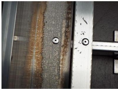
9. die mittleren Winkel ausrichten auf ein Maß von ca.0,53m und auf die Unterkonstruktion nieten.
