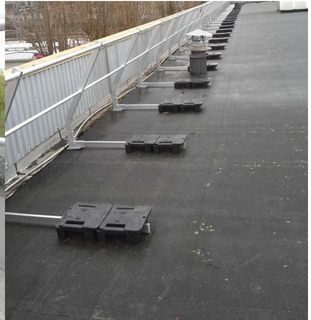
30° geneigtes selbsttragendes Geländer
