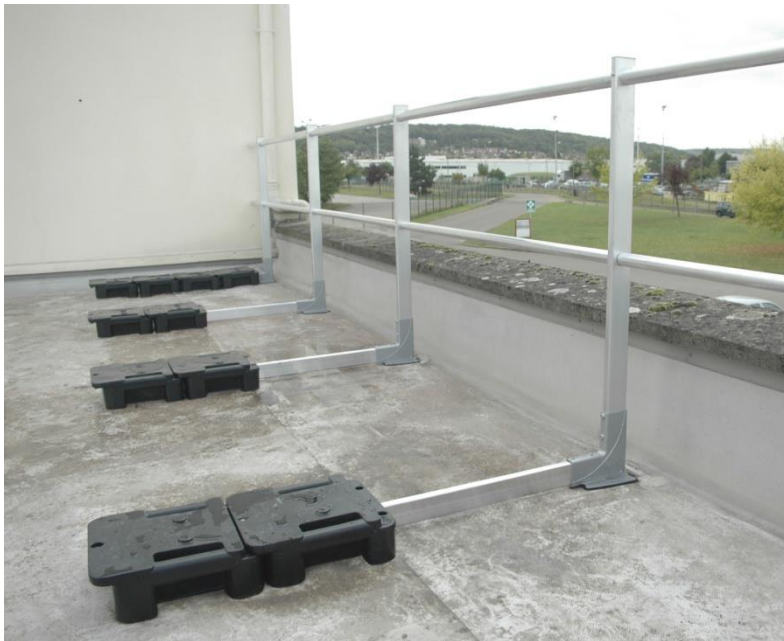
Gerades selbsttragendes Geländer
